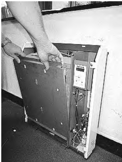
⑩取外しと逆の手順でインナーパネルを取付けビスで取り付けます。 ※インナーパネルに取り付けられているマイクロサーム断熱材を痛めない様に十分注意してください。
