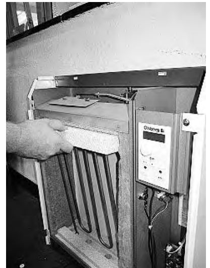
⑥ヒーターを固定している発泡スチロールのパッキン材を取り除きます。
