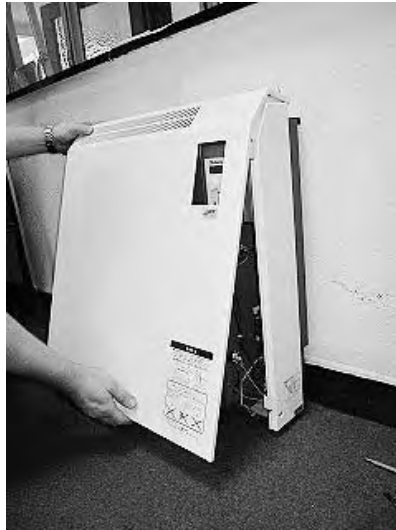
②前面パネル下部を手前に引きながら上に持ち上げると前面パネルが外れます。
