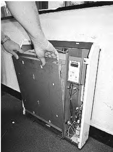
④インナーパネルの上方を手前に引きながら上に持ち上げるとインナーパネルが外れます。
