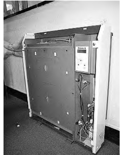
③前面パネルと前面インナーパネルの間にある発泡スチロールのパッキン材を取り除き、インナーパネルを固定しているビスを全て外します。
