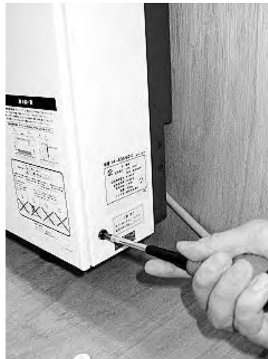
⑪取付けと逆の手順で前面パネルを取付けビスで固定、ビスキャップを取付けてください。
